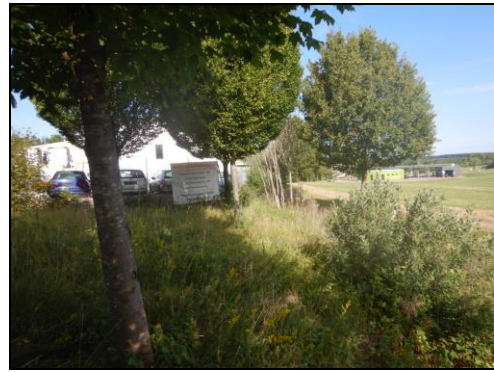
Übersicht angrenzender Wassergraben
